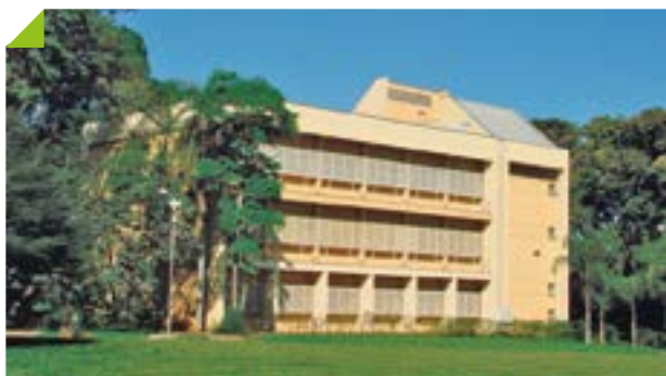
Prédio do Centro de Estudos Avançados em Economia Aplicada | Créditos: Acervo ESALQ
