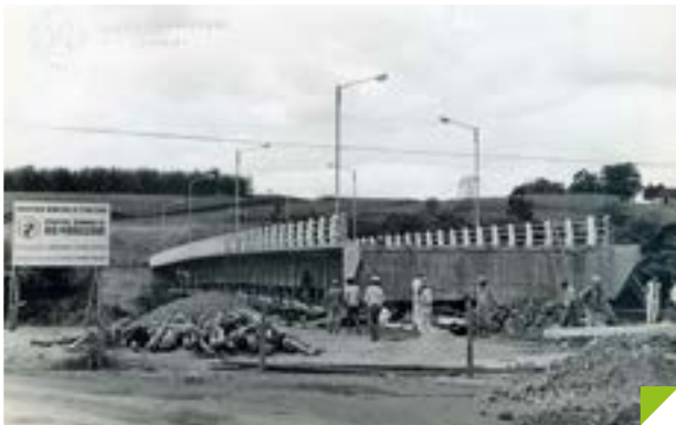
Obra da ponte sobre o Rio Piracicaba Créditos: Acervo IHGP
