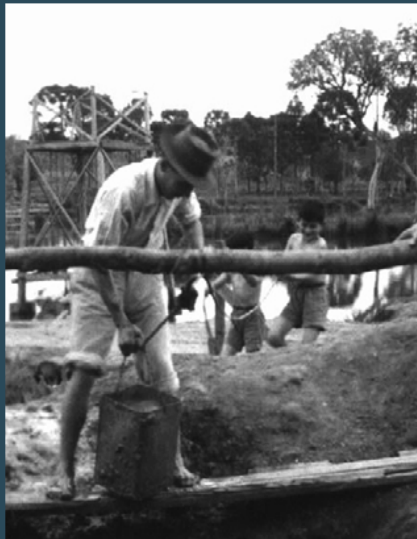
1943 Butiá, Guilhem e eu, que não apareço porque estava dentro, cavando o poço
